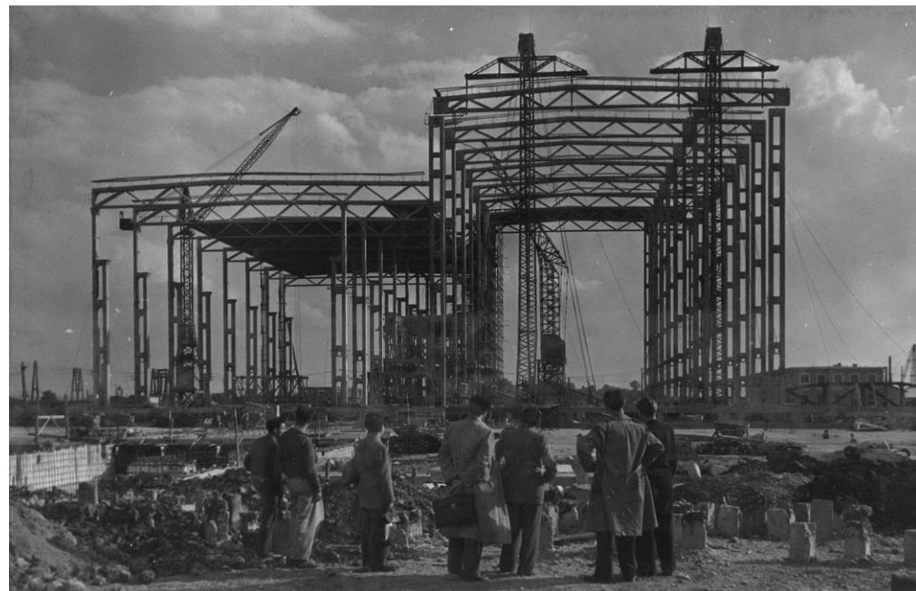
Erőmű-főtartó beemelése / Tiszapalkonya / 1953 / IPARTERV - Mátrai Gyula, Pászfi Károly
