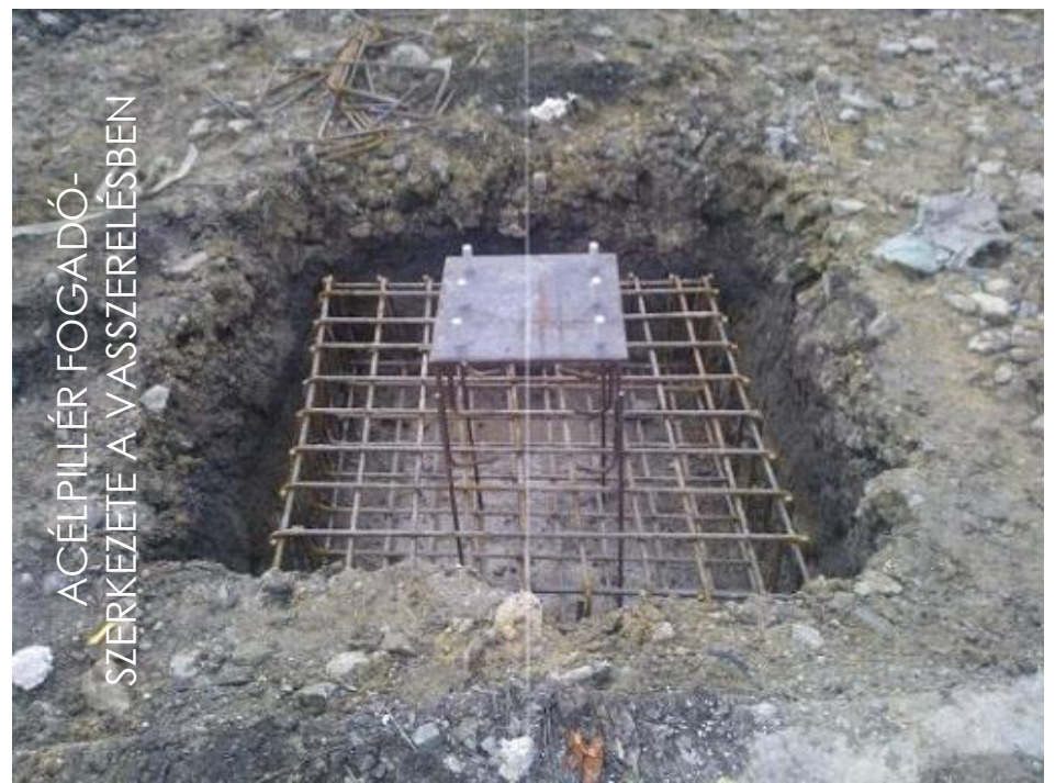
Monolit vasbeton pontalap vasszerelése acél talplemezzel, tőcsavarokkal
