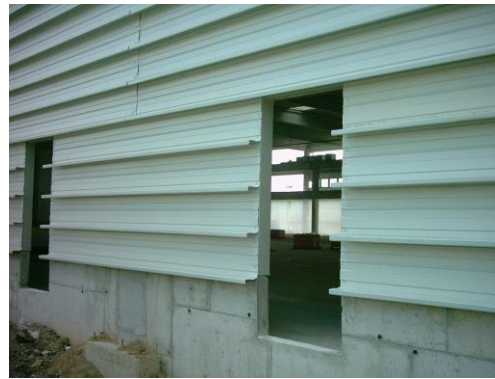
VÍZSZINTES ACÉL „KAZETTA” HŐSZIGETELÉS ÉS BURKOLÁS ELŐTT
