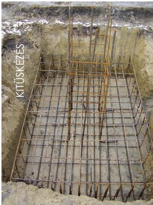
Monolit vasbeton pontalap vasszerelése
