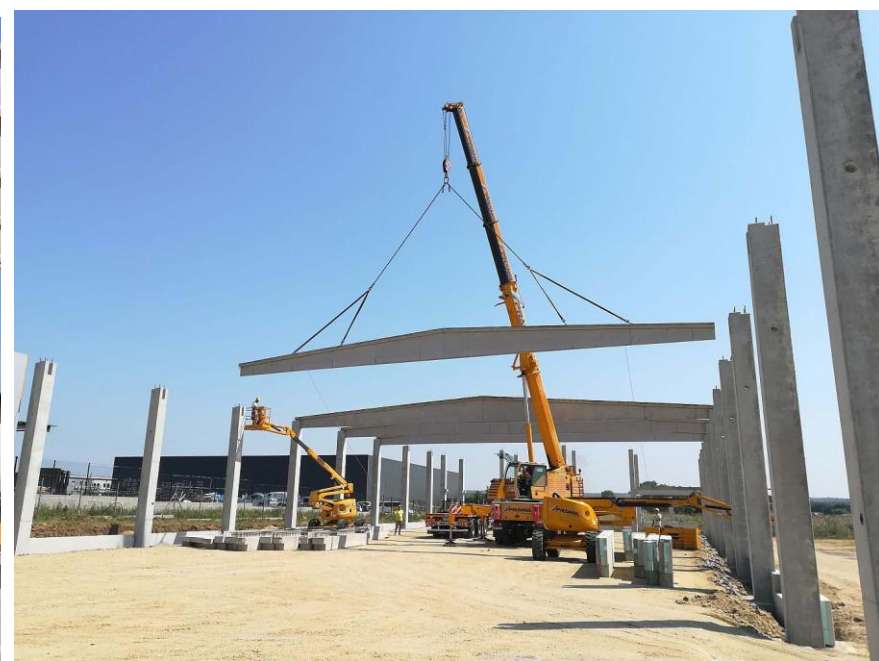
Hosszfőtartók beemelése – forrás: elsobeton.hu
