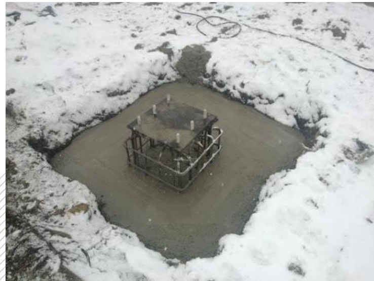
Monolit vasbeton pontalap betonozás után acél talplemezzel, tőcsavarokkal
