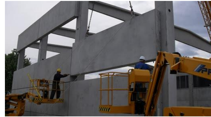
VÍZSZINTES BETONPANEL BEEMELÉSE
