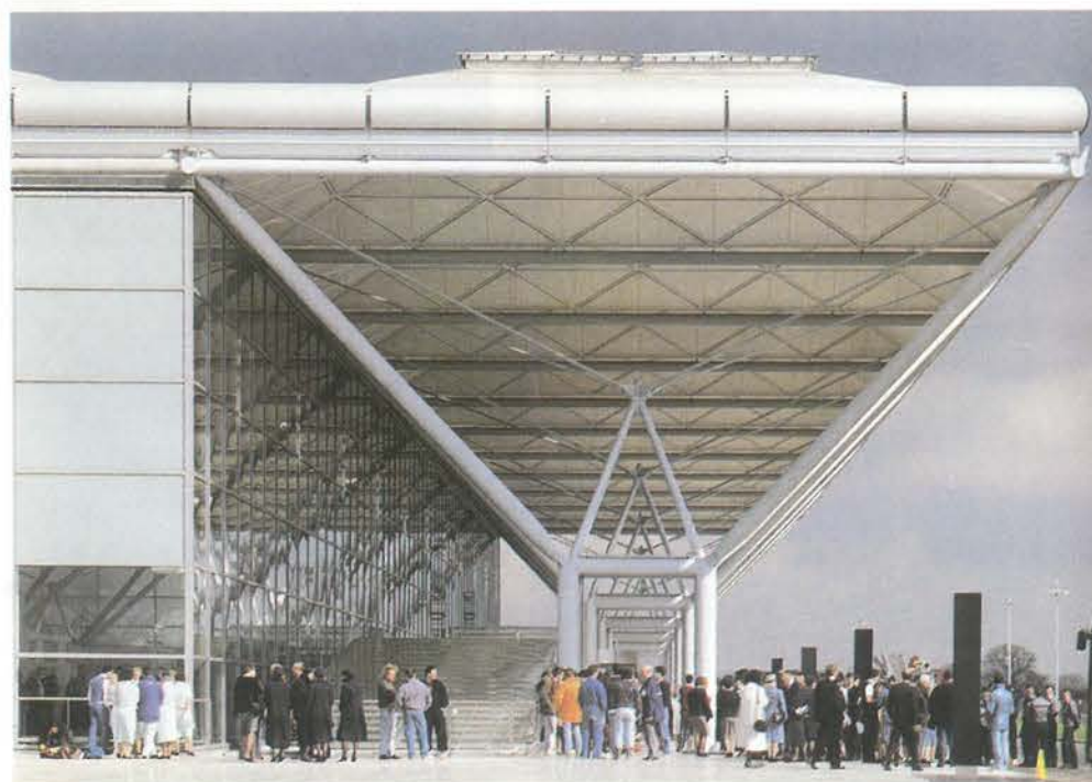
18.38. ábra. Repülőtér – Stansted/Nagy-Britannia, 1987–1991 (Sir Norman Foster & Ass.). Az egy szintre rendezett érkezési és indulási funkciókat 12 méter magas acélszerkezetű fákra támaszkodó, 15 méter magasan húzódó – részben üvegezett – felület fedi.
