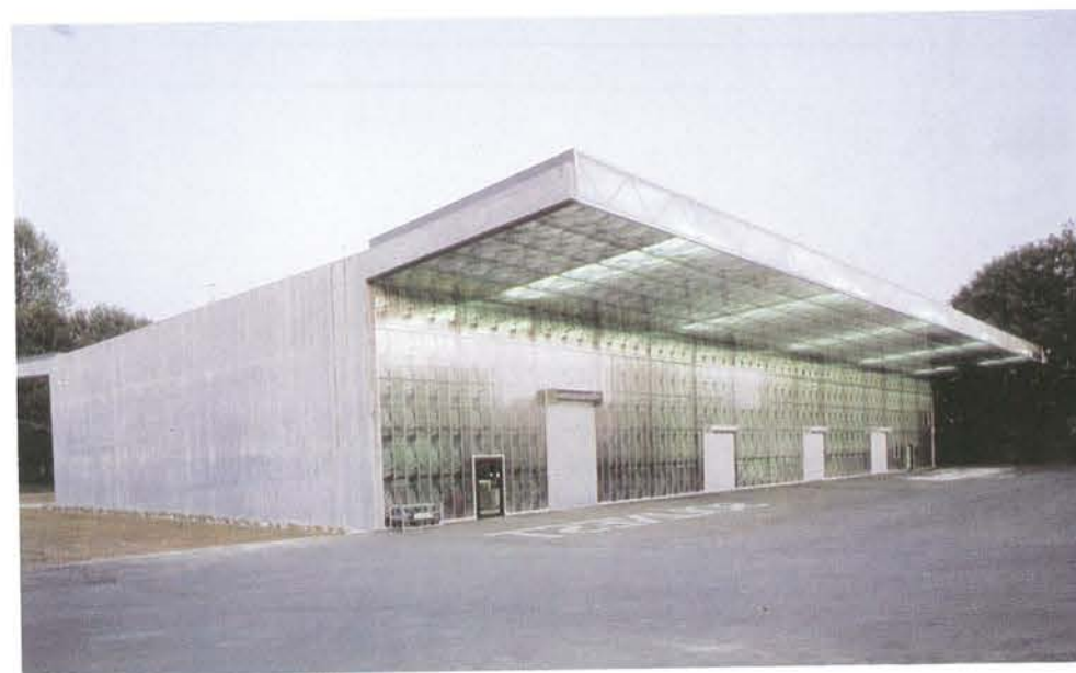
18.19. ábra. Ricola AG üzemi épület – Mülhausen/Franciaország, 1995 (Herzog & de Meuron). A svájci édességyárgyár "bonbonosdoboz" a temperált raktározás feltételeinek biztosításával háromrétegű szitanyomott polikarbonát-lemez transzparens burkolattal.
