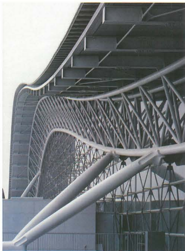
18.40. ábra. Kansai Nemzetközi Repülőtér Oszaka /Japán, 1994 (Renzo Piano és Noriaki Okabe). Az oszakai öbölben létesített mesterséges szigetre épült a lineáris elrendezésű felvételi épület. A lefedés rácsos acélszerkezete hullámos felületet képez.
