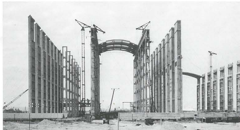
18.47. ábra. Hőerőmű szerkezete – Pécs, 1958 (Mátrai Gyula és munkatársai, Iparterv) Az 1950-es évek nagyelemes helyi előregyártásának kiváló példája.
