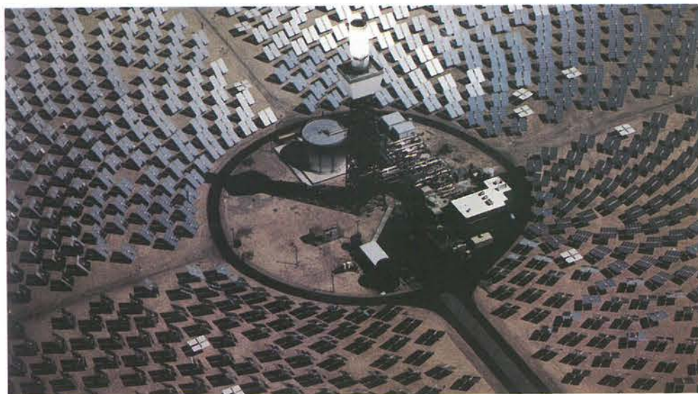
18.54. ábra. Kísérleti napenergia-telep – Kalifornia/Amerikai Egyesült Államok. A napenergia hasznosítása egy pontra irányított számítógéppel vezérelt tükörrendszer segítségével. A fókuszpontban lévő berendezésben lévő folyadék a magas hőmérséklet hatására gőzzé válik, mely turbinát hajt, így elektromos energia keletkezik.
