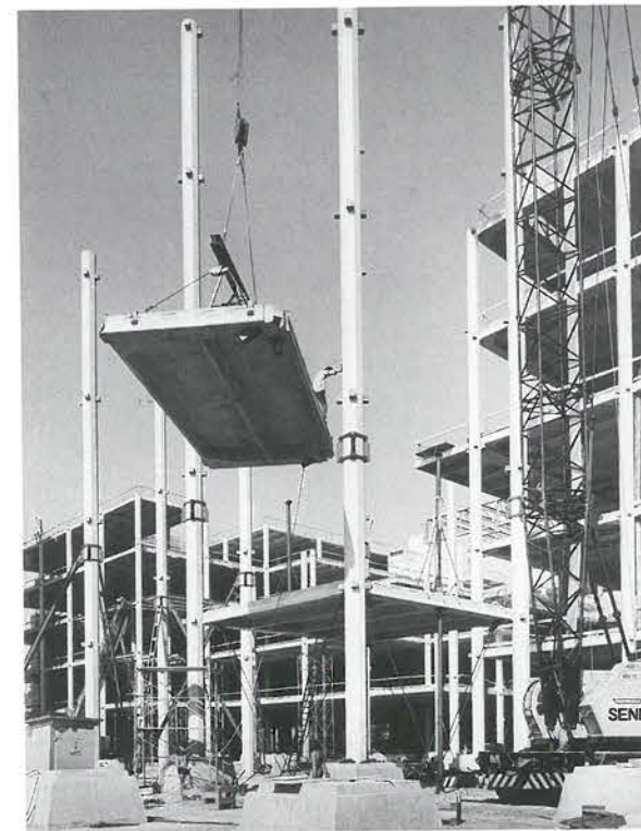
18.49. ábra. A Haditengerészet javítóüzeme – Garden Island/Sydney/Ausztrália, 1985 (Harry Seidler & Ass.). A nagy fesztávolságú, nagy teherbírású, többszintes, daruzott műhelyépület egyedi előregyártású, utófeszített vasbetonszerkezettel készült.
