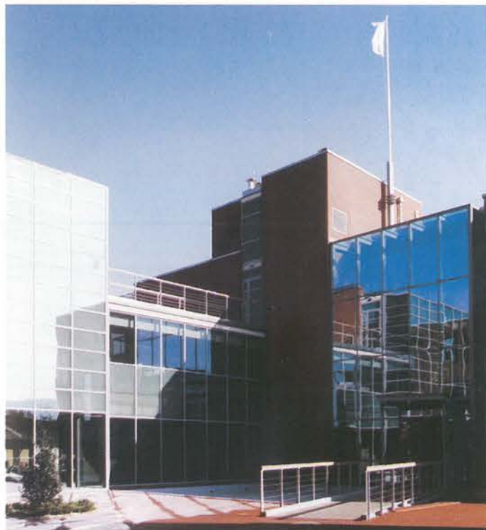
18.29. ábra. Graphisoft Park – Budapest, 1999–2000 (Cságoly Ferenc, Keller Ferenc Építész Stúdió Kft.). Az óbudai Gázyár rehabilitációs területén létesített irodapark példaértékű épületei.
