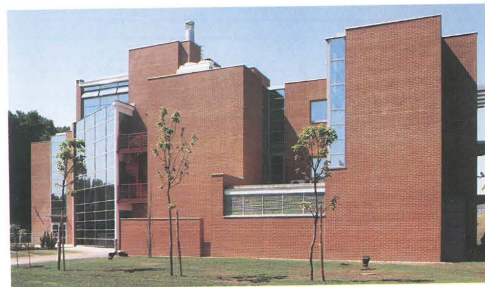
18.30. ábra. Graphisoft Park, Microsoft-székház – Budapest, 2000 (Sylvester Ádám, Tér 4 Kft.). Belső udvar köré szervezett, gazdag vizuális kapcsolatokkal kialakított épület. Megjelenése harmonizál a páratlan Dunaparti környezettel és a parkban a közelmúltban épült épületekkel. Foto: Häider Andrea.
