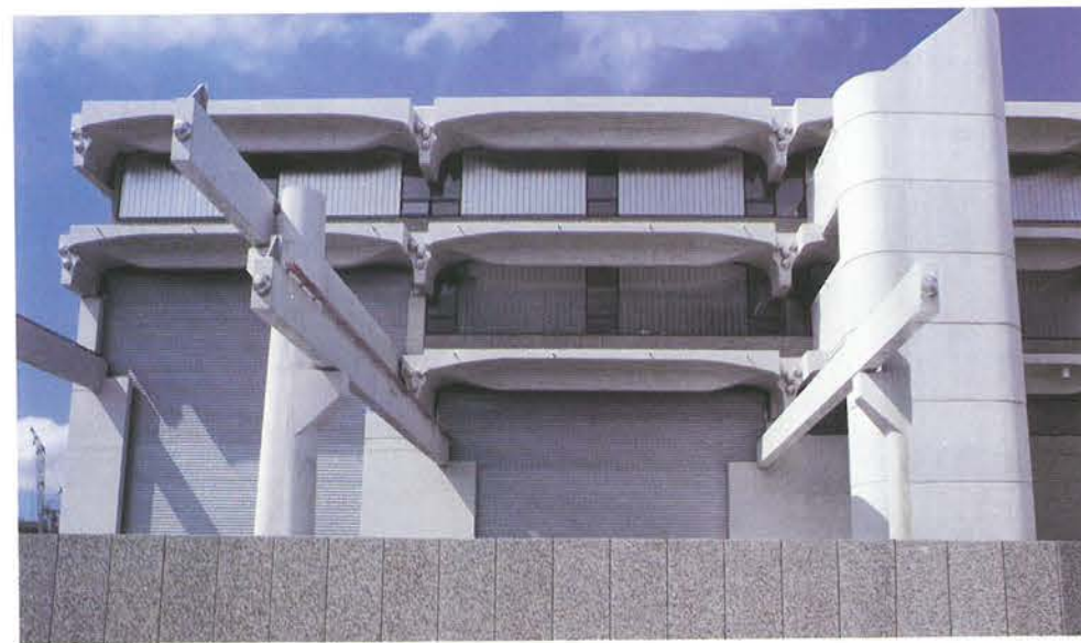
18.49. ábra. A Haditengerészet javítóüzeme – Garden Island/Sydney/Ausztrália, 1985 (Harry Seidler & Ass.). A nagy fesztávolságú, nagy teherbírású, többszintes, daruzott műhelyépület egyedi előregyártású, utófeszített vasbetonszerkezettel készült.
