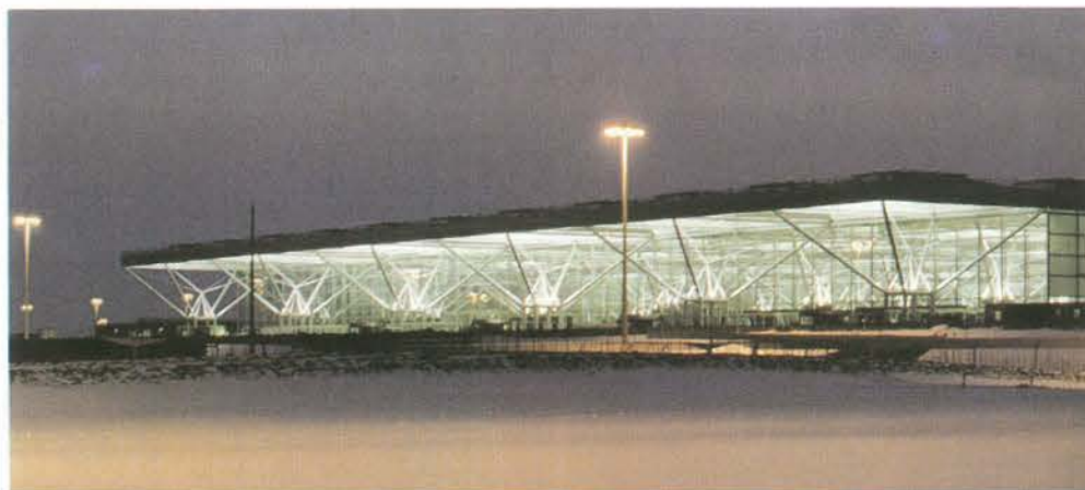
18.38. ábra. Repülőtér – Stansted/Nagy-Britannia, 1987–1991 (Sir Norman Foster & Ass.). Az egy szintre rendezett érkezési és indulási funkciókat 12 méter magas acélszerkezetű fákra támaszkodó, 15 méter magasan húzódó – részben üvegezett – felület fedi.
