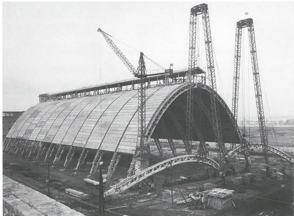
18.46. ábra. Sóraktár a Borsodi Vegyi Kombinátban – Kazincbarcika, 1953 (Szerkezet: Gnädig Miklós és munkatársai, Iparterv). Nagyelemes helyszíni előregyártással készített, háromcsuklós keretszerkezet.
